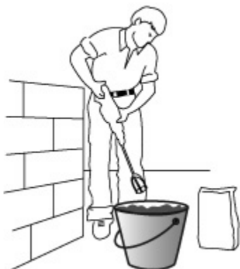
Fig 2. Es conveniente contar con el batidor para ajustar la consistencia de la mezcla. Esto evita que quien prepare la mezcla le incorpore exceso de agua al balde.
